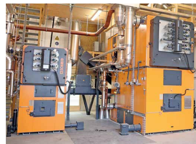
Schmid Vorschubrostfeuerung Kessel 1: UTSR-1600.32-1 visio / Kessel 2: UTSR-550.32-1 visio
